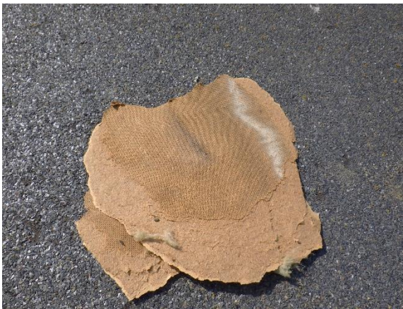
Rakennevauksen RA.05 alimman kovalevyn sisäilmaan yhteydessä oleva pinta
