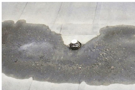
Kattokaivon lähellä paikoitellen veden keräämää likaa
