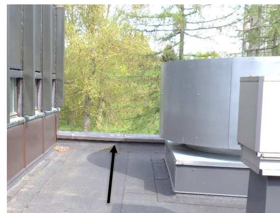
Räystään reunanostoissa ei havaittu puutteita
