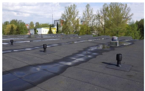
Korkealla keskiosalla alipainetuulettimilla tehostetaan yläpohjan tuuletusta
