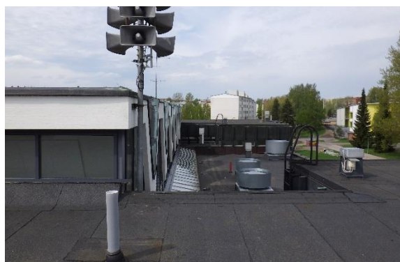
Yleiskuva rakennuksen pohjoispään alatasolta
