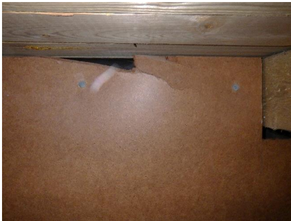
Kattoikkunan vierellä pystyyn asennettu kovalevy
