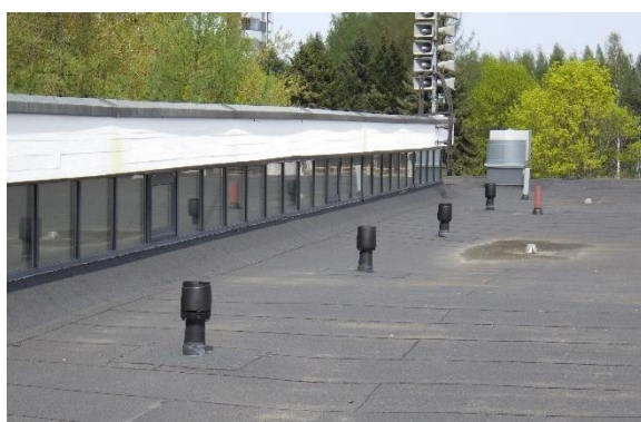
Alipainetuulettimet tehostavat tuuletusta
