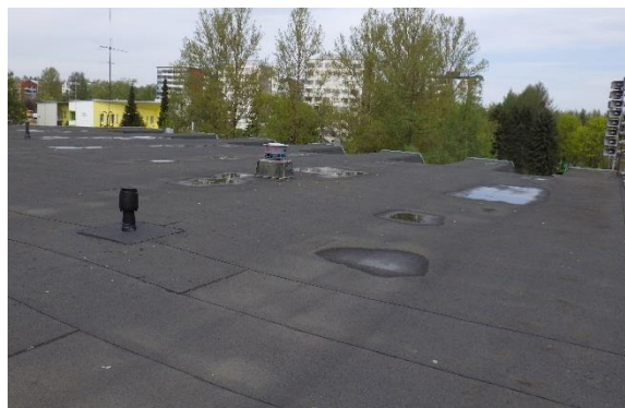
Yleiskuva rakennuksen ylimmältä keskiosalta
