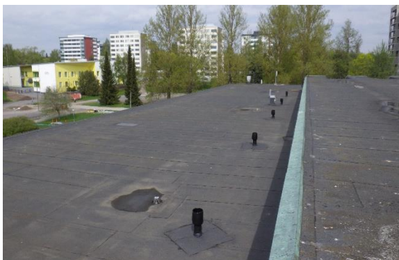
Yleiskuva rakennuksen pitkän sivun vesikatolta
