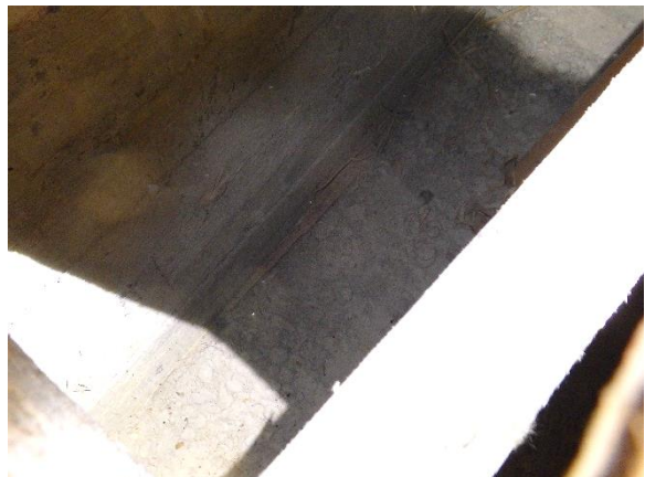
Korkea ilmatila puukoolauksen alapuolella
