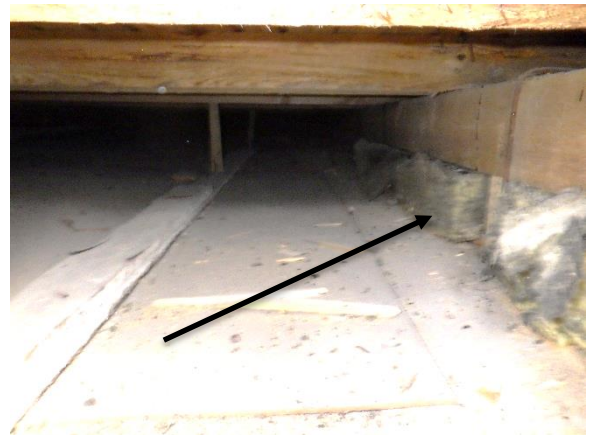
Kattoikkunalinjalla kovalevyn päällä mineraalivillaa
